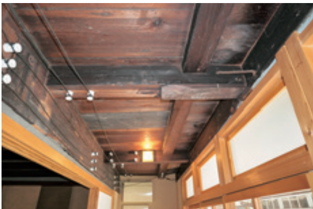
図24 正面下屋上部の土居桁（物件番号15）
