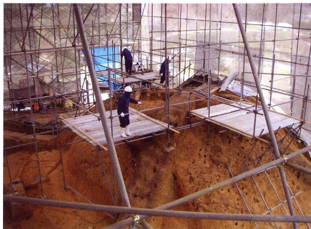
Fig. 38 試料採取に向けた足場の設営状況 (墳丘と石室への影響を避けるために古墳全体を覆う仮覆屋基礎から組み上げている)
