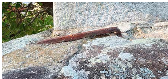
図3 鋸とモルタルによる部材の接合
