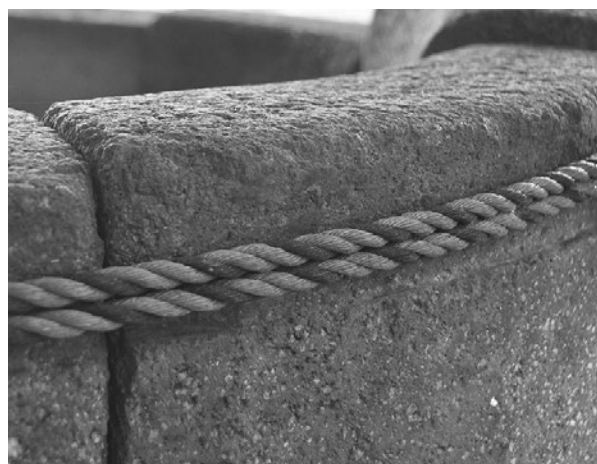
2 井戸枠上部 幅 7.5cm の範囲を 1 cm 程削り込む
