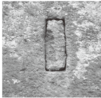
9 側面①の上部枅穴 9×4cmを測り、可塑性の素材 で埋められている
