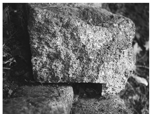
7 ④上・下段の組み合わせ加工 削り込んで、内・外部に段を作り出す ③も同様の加工
