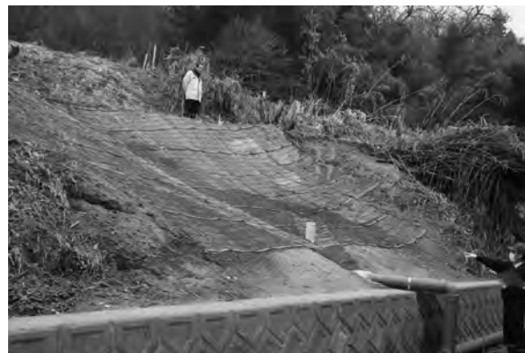
図7 左沢楯山城跡での法面復旧状況
