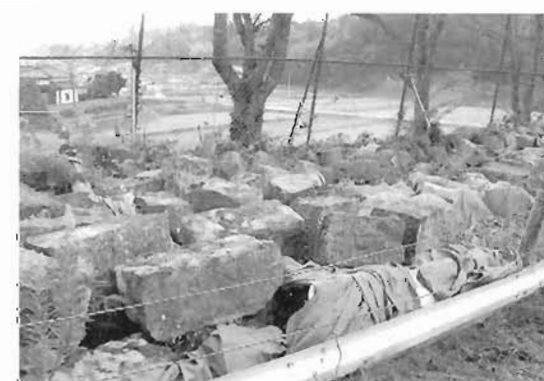
解体後の石材保管状況
