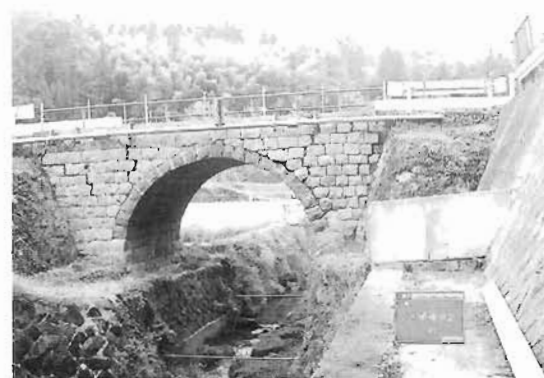
清掃後（下流側）
