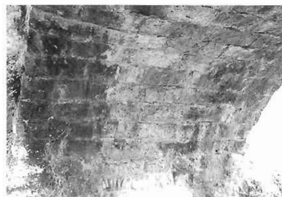
着工前（輪石部）
