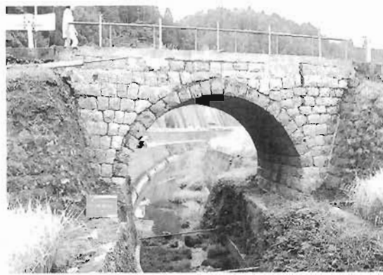
清掃後（上流側）
