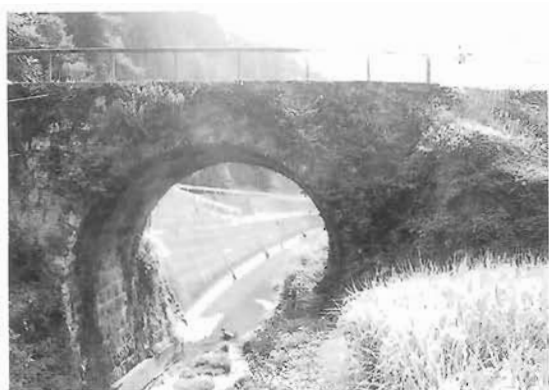
着工前（上流側）
