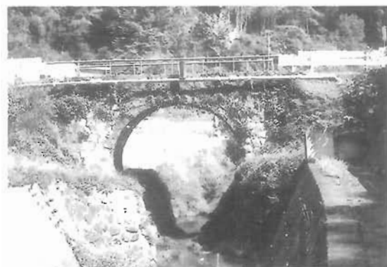
着工前（下流側）
