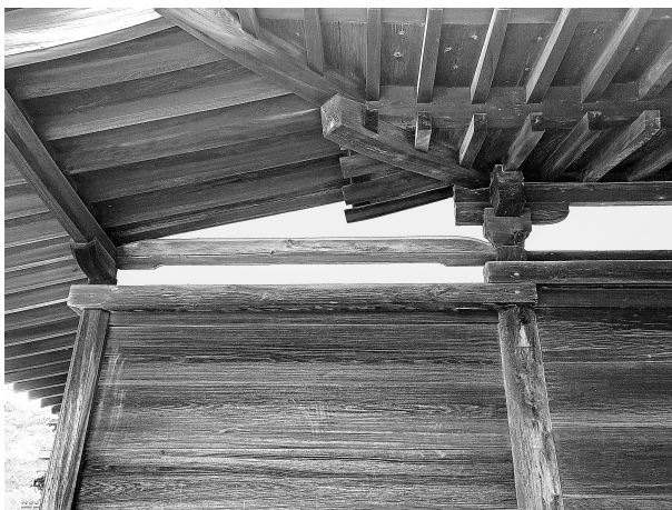
図4 鶴林寺太子堂の廂と孫廂の組物
