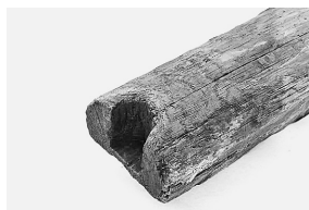
図14 91桁材下面の丸ホゾ穴
