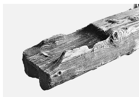
図13 91桁材上面の仕口
