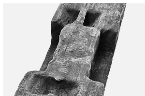
図7 92桁材上面の渡脛仕口
