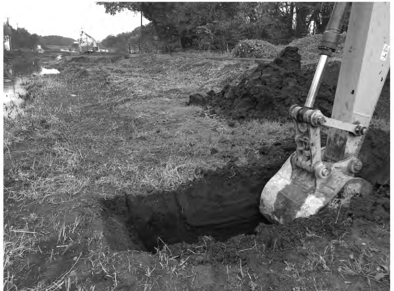
写真1 トレンチ掘削状況
