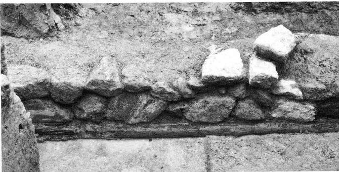
第46図 民家敷地基礎と 胴木(北から)
