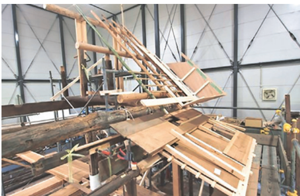
図 18 令和 3 年度仮組調査の様子
