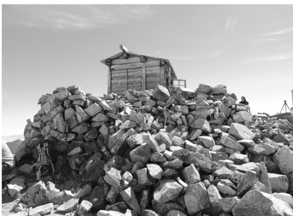
西側石積みの崩落状況
