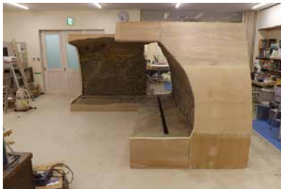
5. 【工程 9-(4)】 側面下地加工 2
