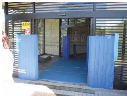
1. 【設置準備：養生】資料館入口
