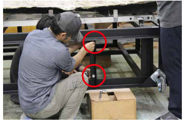
2. 【手順 3-③】奥壁取外し作業状況 2
