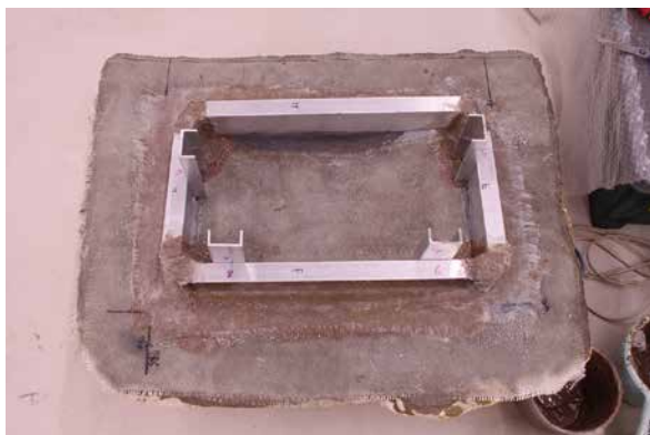
1. 【工程 3-(4)】骨組みの取付け①
