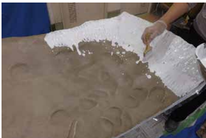
1. 【工程9-(2)】石膏貼り込み(天井)
