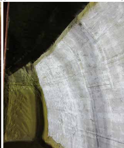
4. 掘削作業完了後の状況 (左壁)
