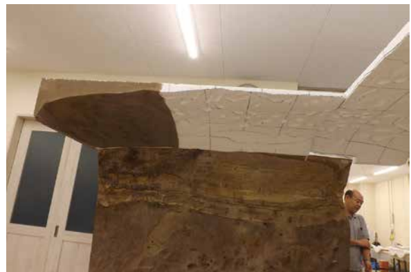
6. 【工程9-(1)】色見本取り(天井)
