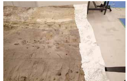
3. 【工程 10-(2)】壁面養生の錫箔 (左側壁)
