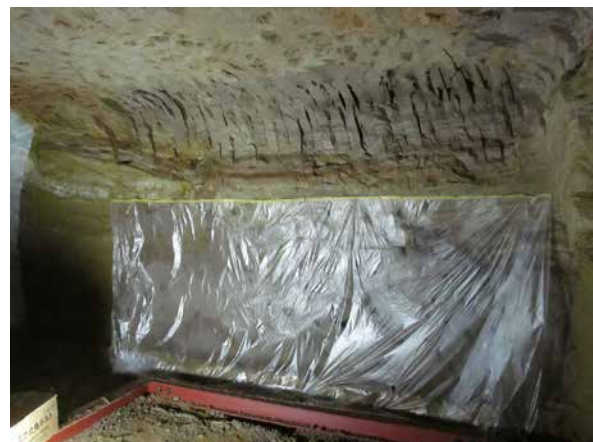
4. 支保工設置状況 (正面: 右側壁)
