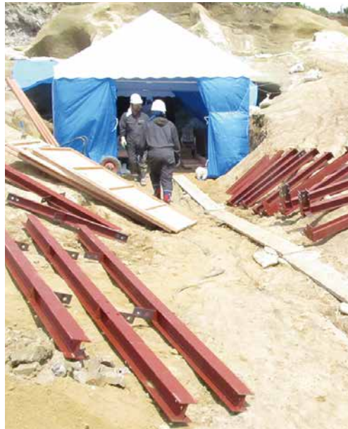
1. 支保工の部材搬入状況
