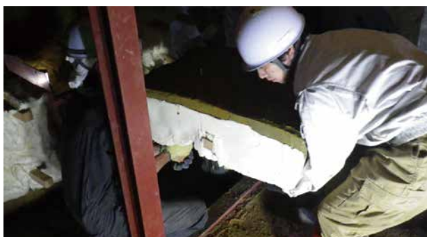
5. 壁面の取出し作業②
