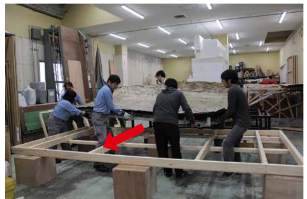
6. 【手順 4】運搬用木枠固定作業状況 1
