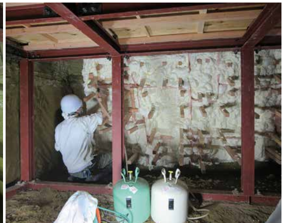
2-5. 奥壁全面への発泡ウレタン樹脂噴霧状況
