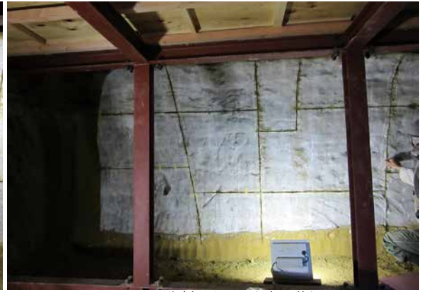
1-3. 分割ラインカット完了状況
