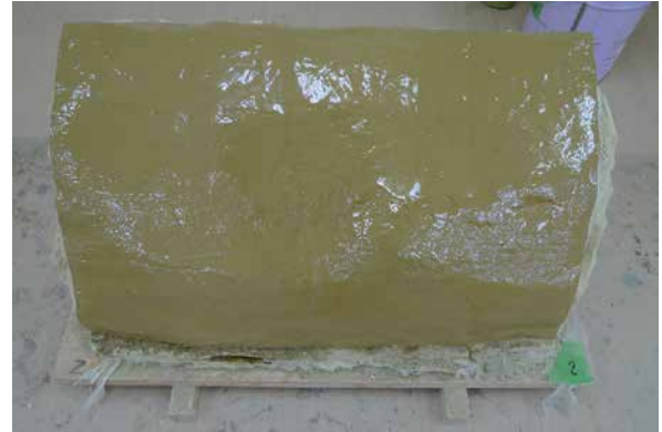
4. 【工程 3-(2)】エポキシ樹脂塗布後 (壁番号②)
