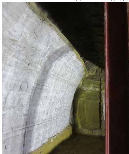
3. 掘削作業完了後の状況 (右壁)
