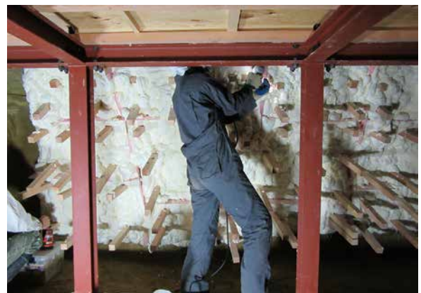
3. 水平レベル確保の作業 (木材の足切断作業)
