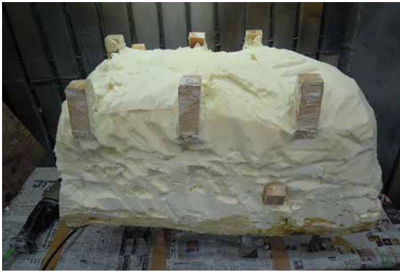
1. 【工程 4-(1)】ウレタン樹脂除去前 (壁番号⑥)
