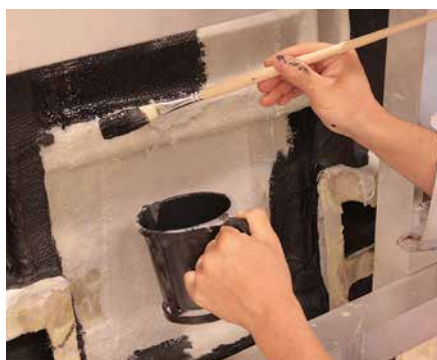
4. 【工程 8-(2)】 フレーム背面の塗装
