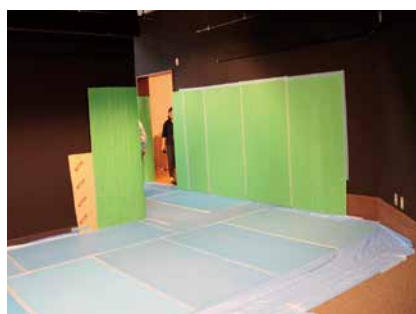
4. 【設置準備：養生】38号墓線刻壁画展示室
