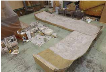
1. 【工程 9-(4)】 骨組みに成形品を取付け
