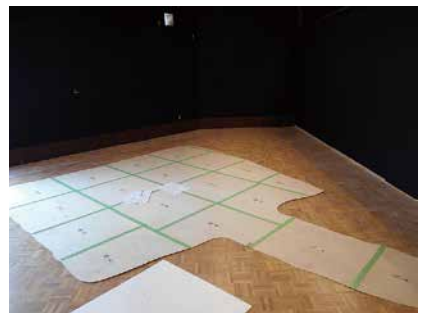
5. カーペット設置作業（施工前）
