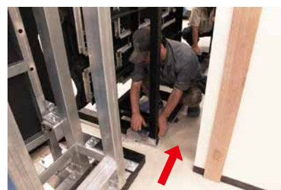
3. 【手順2】 作業スペース確保の状況
