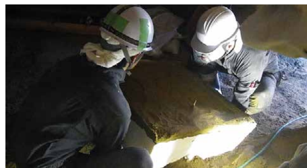
6. 壁面の取出し作業③
