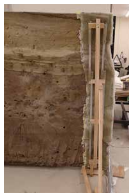
8. 【工程 10-(2)】 バックアップ材作成
