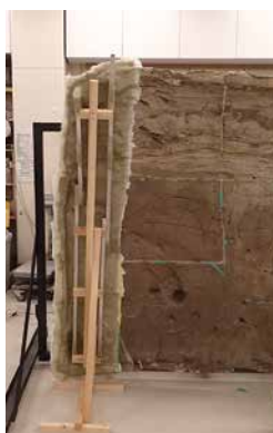
7. 【工程 10-(2)】 バックアップ材作成
