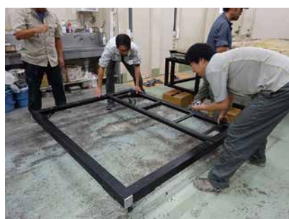
13. 【手順4-③】 左側壁底部骨組取外し作業状況 4
