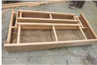
2. 【工程 9-(4)】 骨組み背面
