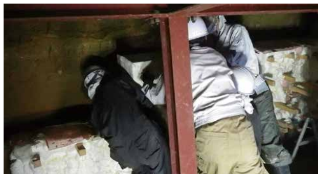
4. 壁面の取出し作業①
