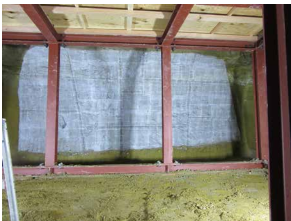
5. 支保工設置状況 (正面: 奥壁)
