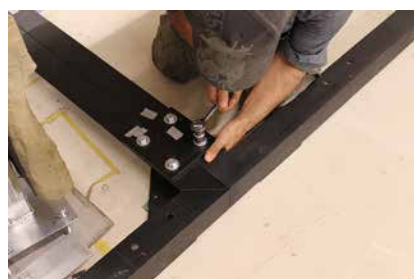
5. 【手順1】 連結パーツ取外し作業状況
