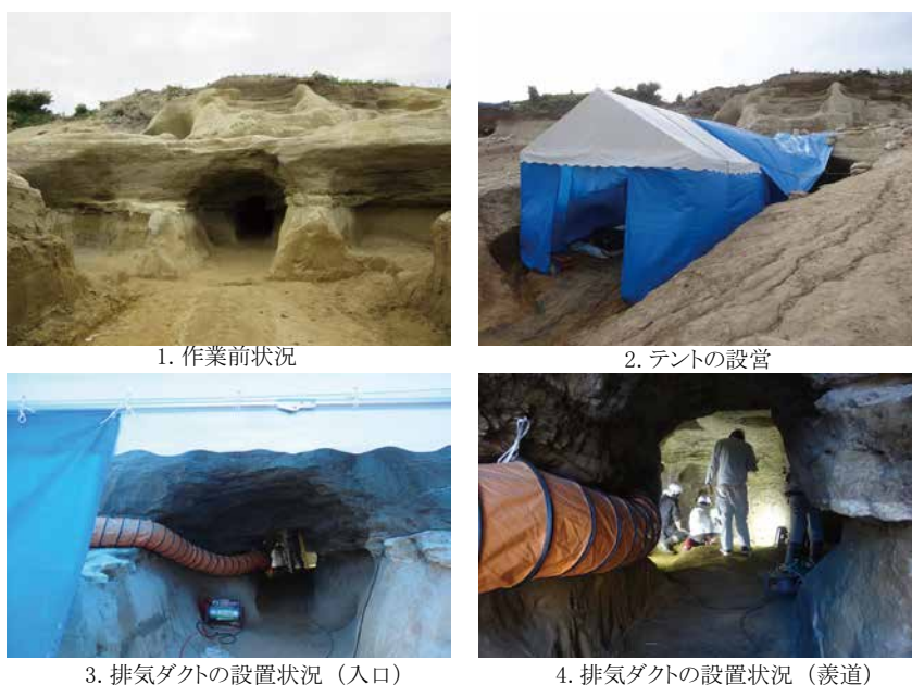
第61図 作業場所の設営状況
