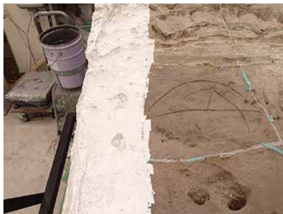
4. 【工程 10-(2)】壁面養生の錫箔 (奥壁)
