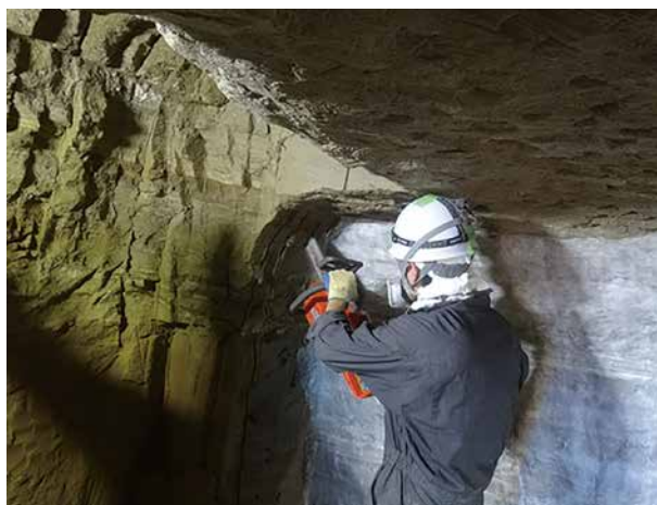
1. 奥壁左壁の掘削状況
