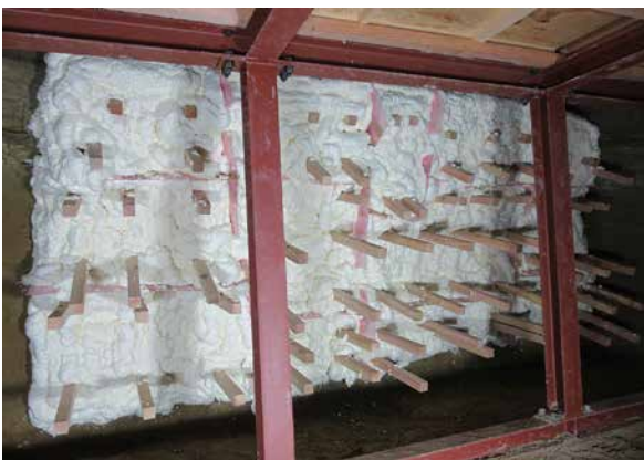
2-6. 受台座完成状況
