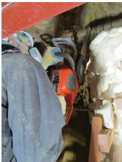
1. チェーンソーでの掘削状況
