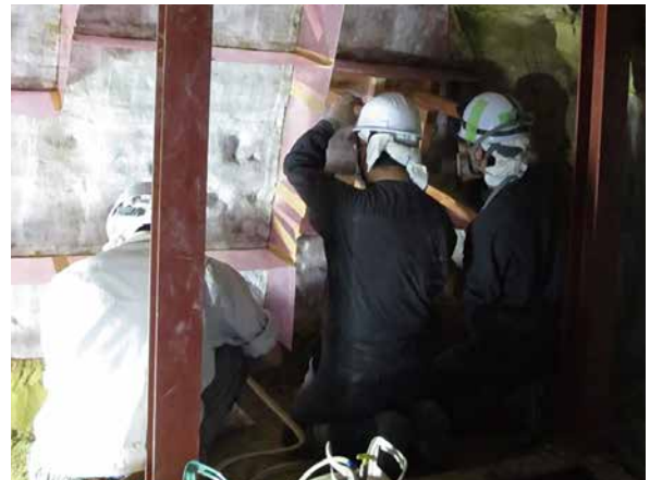
2-2. 発泡ウレタン樹脂噴霧作業
