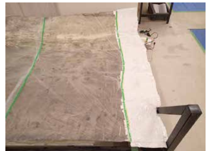
6. 【工程 10-(2)】シリコン樹脂塗布 (左側壁)
