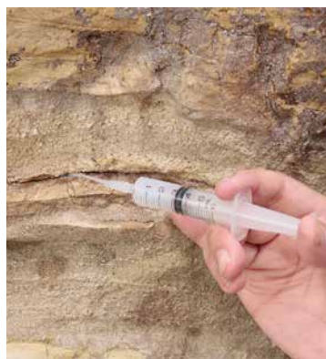
4. 【工程 7-(2)】アクリル樹脂含浸
