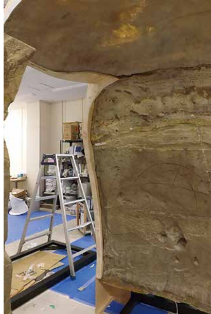
6. 【工程 9-(4)】 側面下地加工 3
