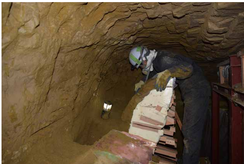
2. 背面の掘削作業①
