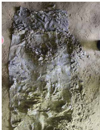
4-1.a 施工部分の壁面転写状況 (上部)
