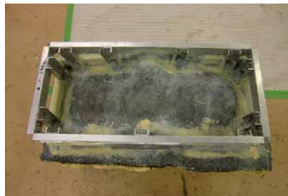
8. 工程 11 背面への骨組み取付状況
