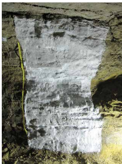
6. 工程3 表面保護作業(2層目)
