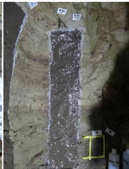
6. シリコン樹脂塗布状況 (左側壁 / 工程6完了後)
