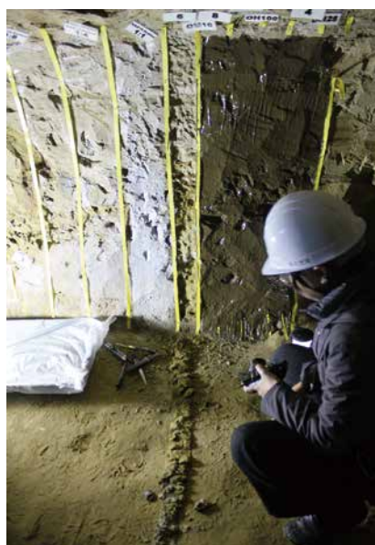
3-1. b 施工部分 [(G)6 部分] の剥ぎ取り状況 ※(G)6 部分のみにカッターを入れ、 シリコン樹脂を切断して剥ぎ取る
