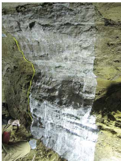
5. 工程3 表面保護作業(1層目)
