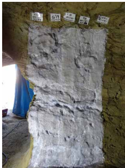
4. ビニロンクロス2層目貼付け状況 (入口付近 / 工程5完了後)
