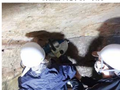
9. 工程 7 大型丸鋸による切り目入れ作業
