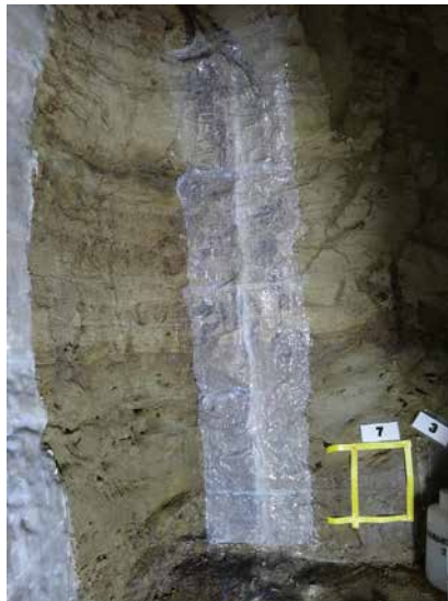
1. ビニロンクロス1層目貼付状況 (左側壁 / 工程4完了後)
