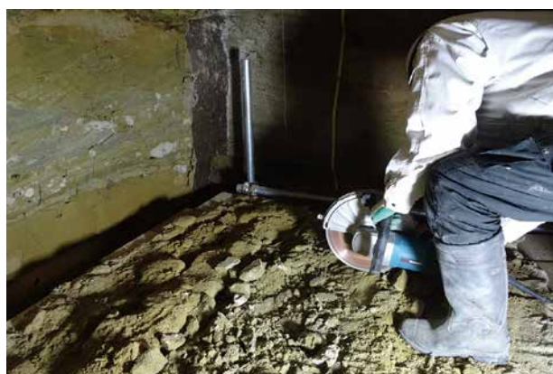
7. 工程 11 剥ぎ取り壁面の分割作業
