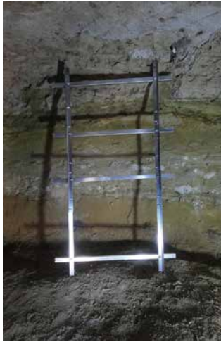
1. 工程6 受部の作成① フレーム作成・取付状況
