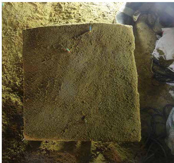
6. 取出しが完了した壁面
