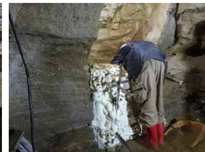
10. 工程8 取出し作業の様子①
