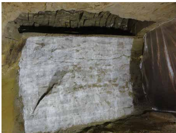
5. 工程 3・4 ガーゼ・ビニロンクロス貼り込み、天井掘削状況
