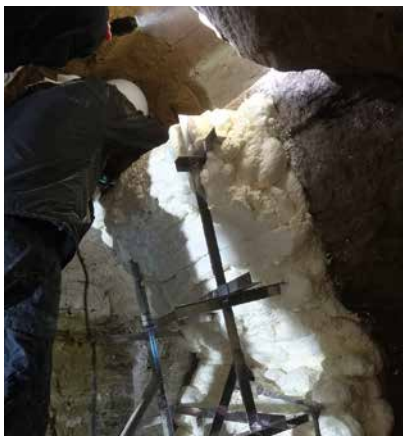
3. 工程7 背面の掘削状況①
