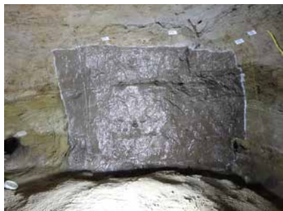
6. シリコン樹脂塗布完了後の状況
