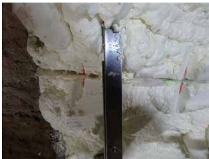
6. 工程8 取出し作業② マーキングの状況
