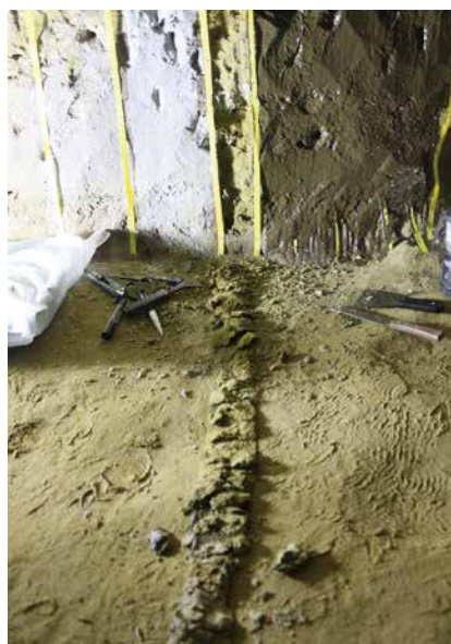
3-2. b 施工部分の壁面転写状況 (全体)
