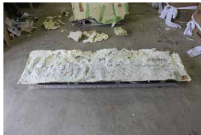
11. 工程 12 ウレタン除去後の状況
