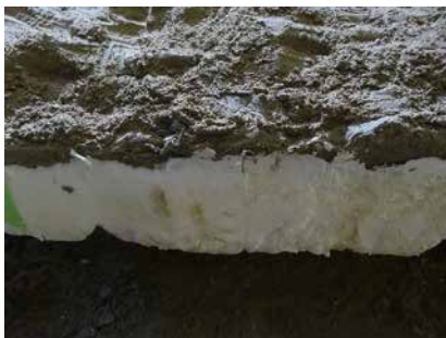
9. 工程8 取出し壁面の断面
