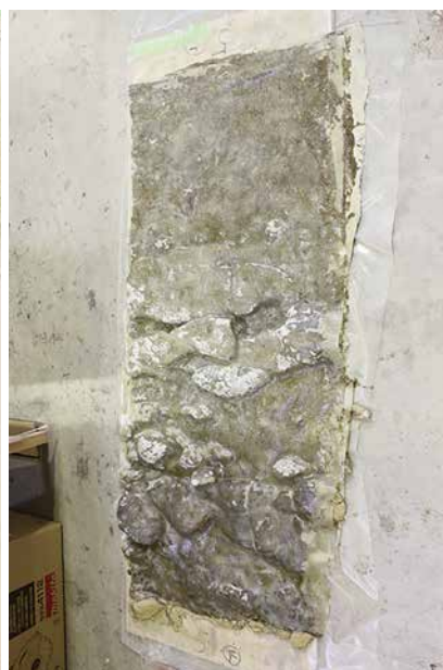
5. 工程 17 壁面の加工状況 (樹脂塗布後の状況: 壁面 B)
