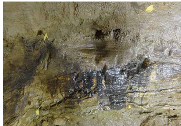
4. 工程 2 壁面へのマーカー設置作業
