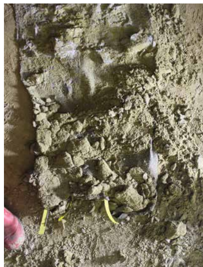
4-3.a 施工部分の壁面転写状況 (下部)
