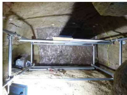
8. 器具組み立て完了
