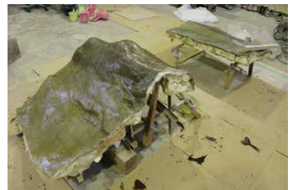
7. 工程 14 エポキシ樹脂・ガラスマット 貼り込み完了後の状況
