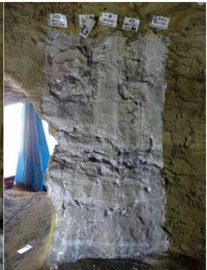
3. ビニロンクロス1層目貼付け状況 (入口付近 / 工程4完了後)
