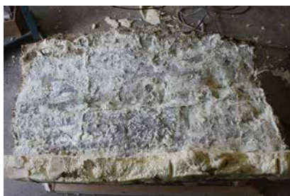
11. 工程 16 表面ウレタン除去完了状況
