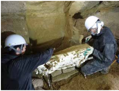
1. 工程 8 取出し壁面の養生作業
