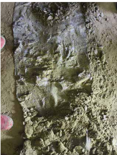
4-2.a 施工部分の壁面転写状況 (中央部)
