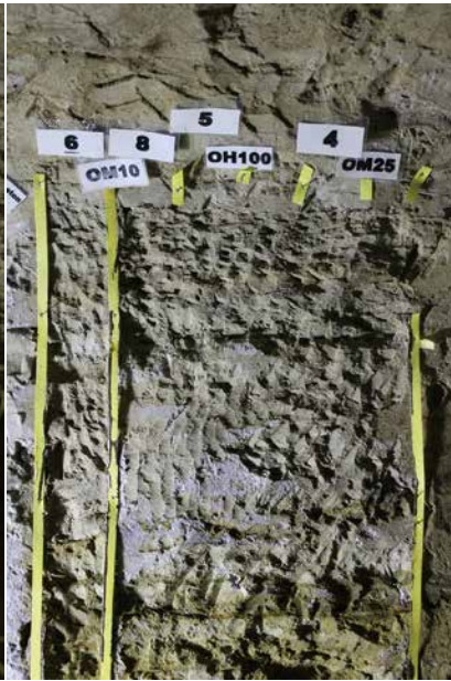
1-2. 転写作業後の左側壁の状況 （上部拡大）
