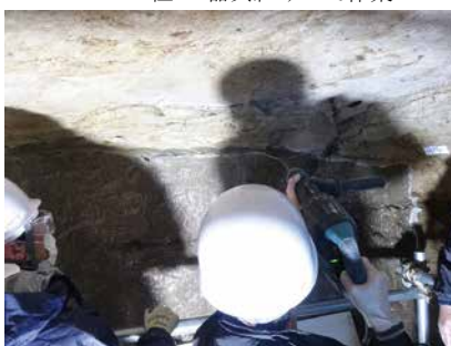
10. 工程 8 電動ハンマによる掘削作業
