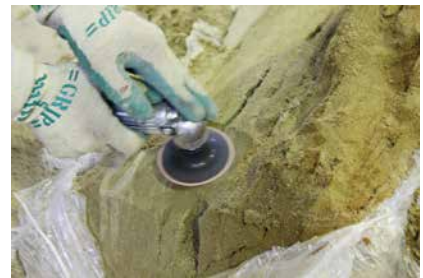
3. 工程 12 背面の土の除去作業
