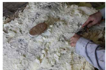
10. 工程 16 表面ウレタン除去作業
