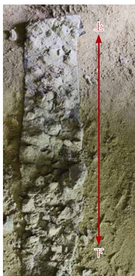
3-3.b 施工部分 (上部)
