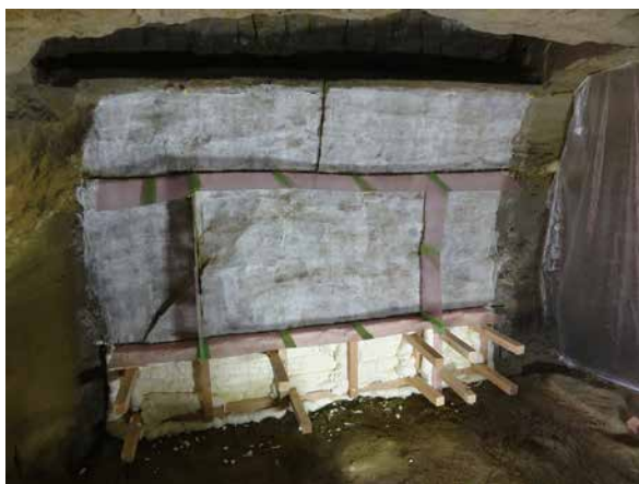
7. 工程 6 受台座の作成① 仕切り板と木製フレームの設置
