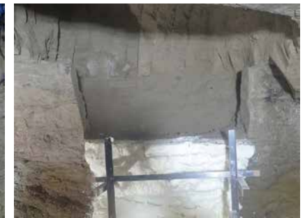
8. 工程8 取出し後の壁面の様子
