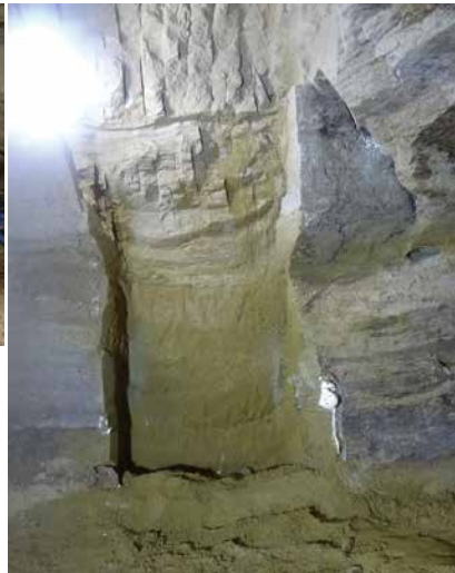
2. 取出し作業完了後の壁面（正面から）
