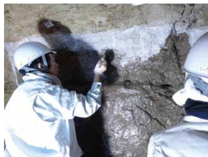
5. 工程 5 シリコン樹脂塗布作業
