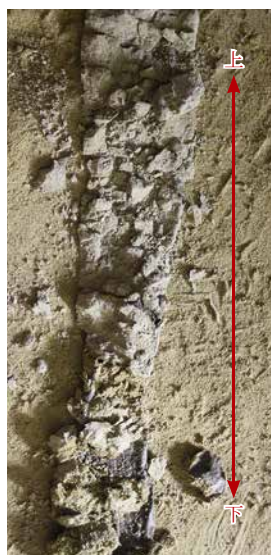
3-4.b 施工部分 (中央部)
