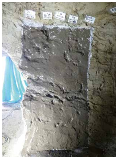
7. シリコン樹脂塗布状況 (入口付近 / 工程6完了後)
