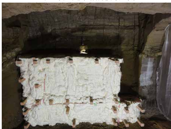
3. 工程 7 壁面の取出し状況①(上段完了後)
