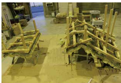
8. 工程 15 壁傾斜再現作業状況
