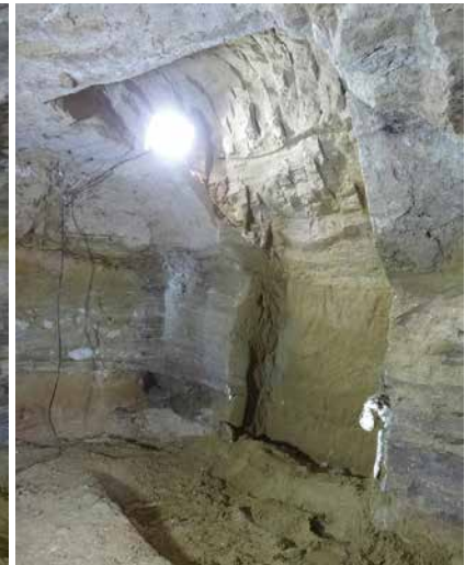
3. 取出し作業完了後の壁面（横から）
