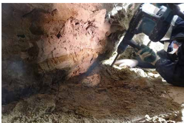
4. 工程 10 転写作業⑤ (電動ハンマによる掘削状況 / 横から撮影)
