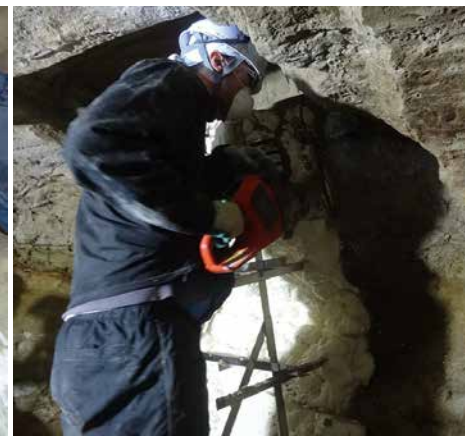
5. 工程8 取出し作業① 両側の切り離し作業
