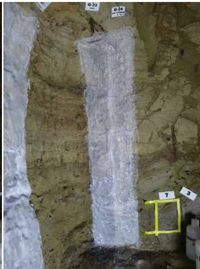
2. ビニロンクロス2層目貼付状況 (左側壁 / 工程5完了後)
