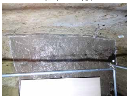
11. 工程 7・8 掘削完了状況
