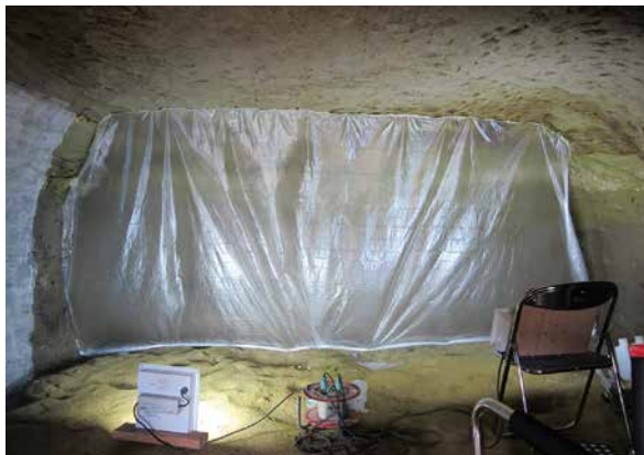
3. 工程 1 奥壁の養生状況
