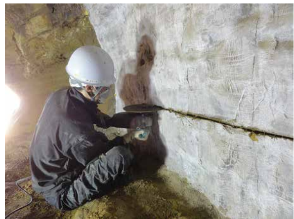
6. 工程 5 分割ラインカット作業
