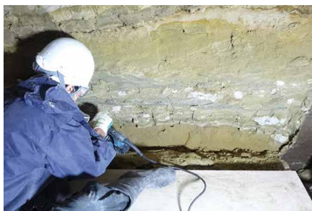
5. 工程 10 転写作業⑥ (電動ハンマによる掘削状況 / 正面から撮影)
