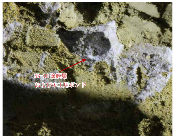
2-4. 転写後の壁面の状況④（中央拡大） ※NS-10 および木工用ボンドの残存状況
