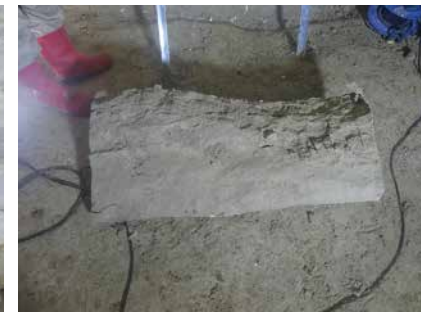
7. 工程8 取出した壁面
