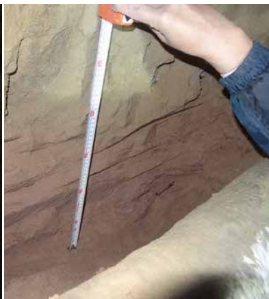
4. 工程7 背面の掘削状況②
