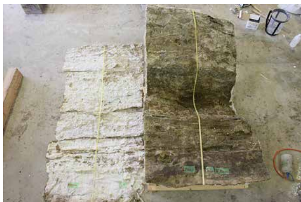
1. 工程 16 ビニロンクロス・ガーゼ除去作業 (壁面左アセトン使用 / 右酢酸エチル使用)
