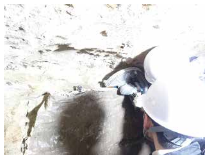
14. 工程 10 転写作業① (大型丸鋸による切れ目を拡大作業)
