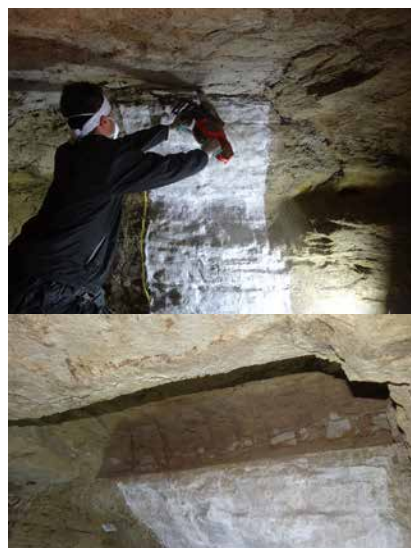
7. 工程4 天井掘削状況
