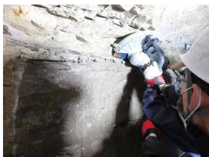
12. 工程 9 大型丸鋸で背面に切れ目入れ
