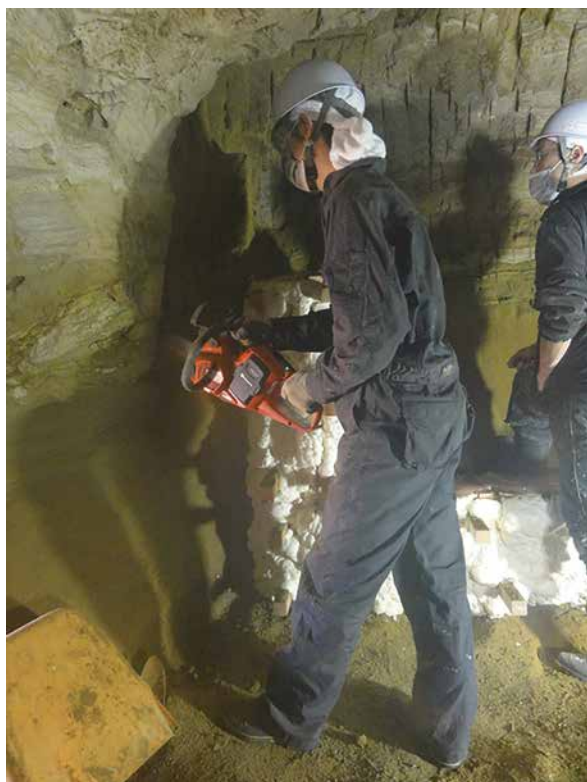
2. 工程 7 左側壁取出し作業
