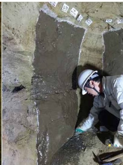
5. シリコン樹脂塗布作業 (工程6作業状況)
