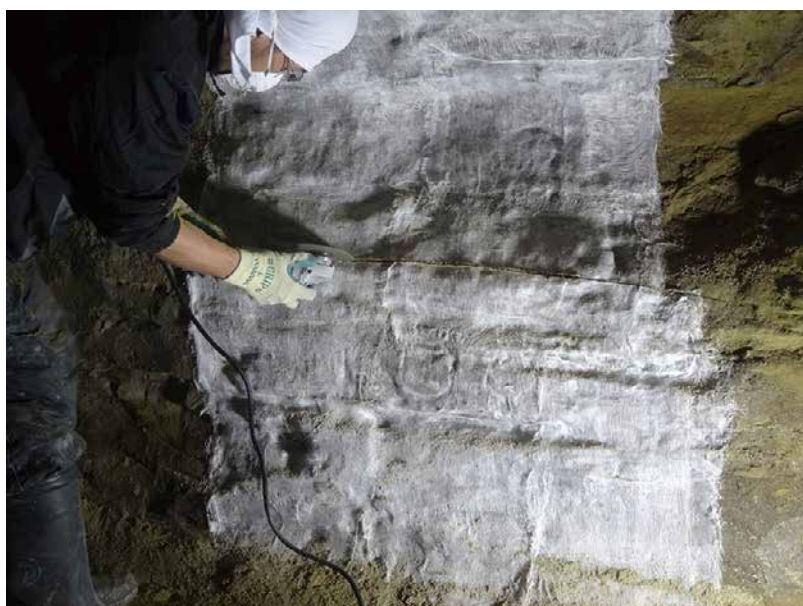
8. 工程5 分割壁面の切れ目入れ作業
