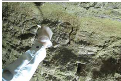
3. 工程2 アクリル樹脂塗布状況
