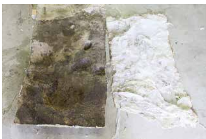
13. 工程 12 ビニロンクロス・ガーゼ除去後
