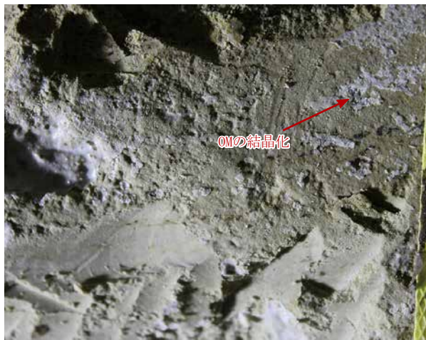
2-3. 転写後の壁面の状況③（上部拡大） ※OM の結晶化範囲の状況
