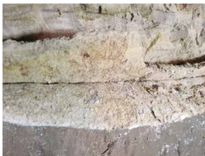
2. 工程 10 転写作業③(剥ぎ取り箇所拡大)
