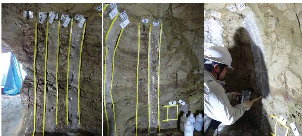
1. 実験箇所①(入口付近 5 か所) ※工程 1～3 完了後
