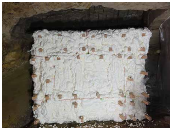
1 工程 6 受座台設置作業完了後の状況
