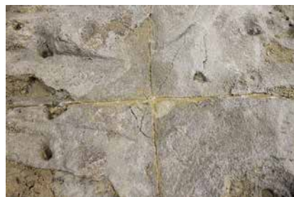
1. 工程 14 各壁面の接合状況 (樹脂流し込み後)
