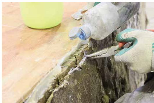
7. 工程 19 壁面の加工状況 (表面のガーゼ除去作業)
