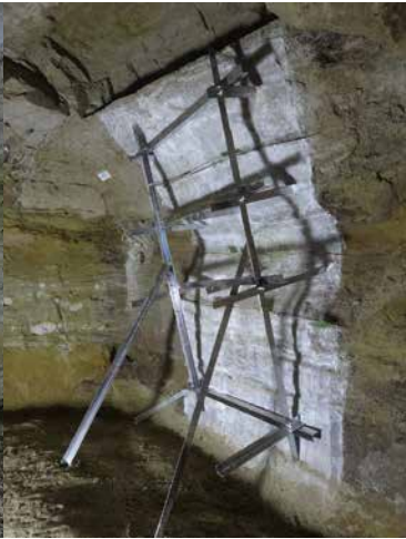
1. 工程6 受部の作成① フレーム作成・取付状況
