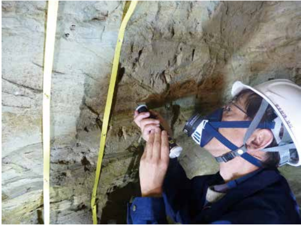
1. 固化状況確認
