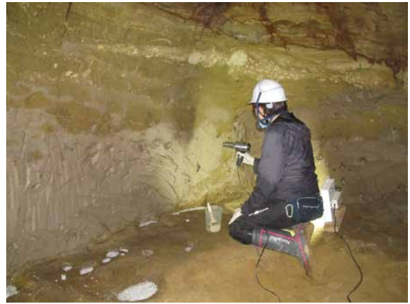
6. 線刻画への施工 (送風による乾燥)
