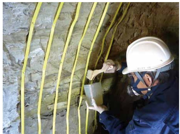
6. 壁面に対する薬剤塗布
