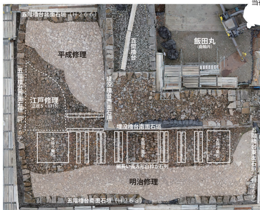
築石 14 段目解体前状況、上が北
