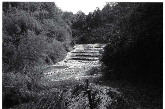
⑥ D 地区 谷戸遠景（北から）
