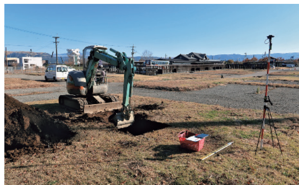
図-4 トレンチ掘削の様子
