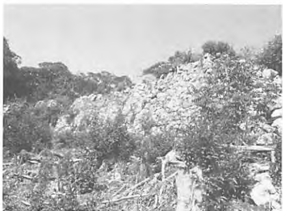
㉒ 東南部の張り出し
