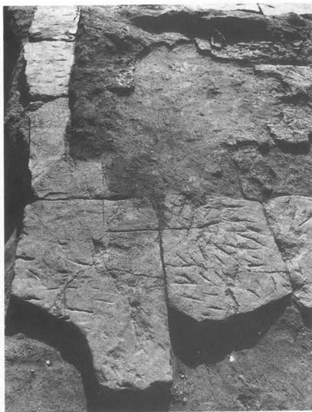
◀ 2. 同上 地覆石と炭化材 〔地覆石上の毛引きは炭化材〕の芯出しと思われる。
