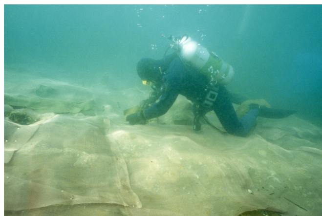
図 5.2 海中生物による食害を防ぐために行われた銅製網による船体被覆作業
