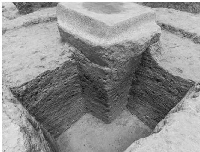
Fig.37 礎石「ろ二」据付穴断面 (北東から)
