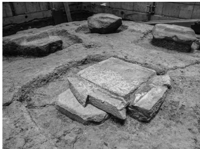
Fig.34 追加の柱座除却後の礎石「ほ二」と飼石 (南東から)
