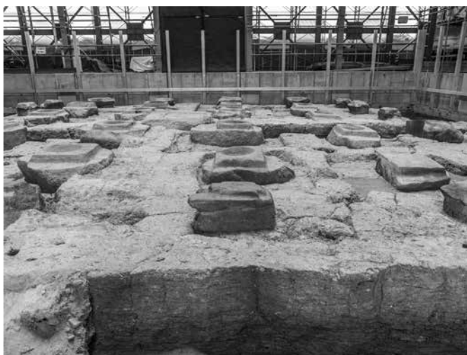
Fig.32 基壇西側における不同沈下した礎石（北から）
