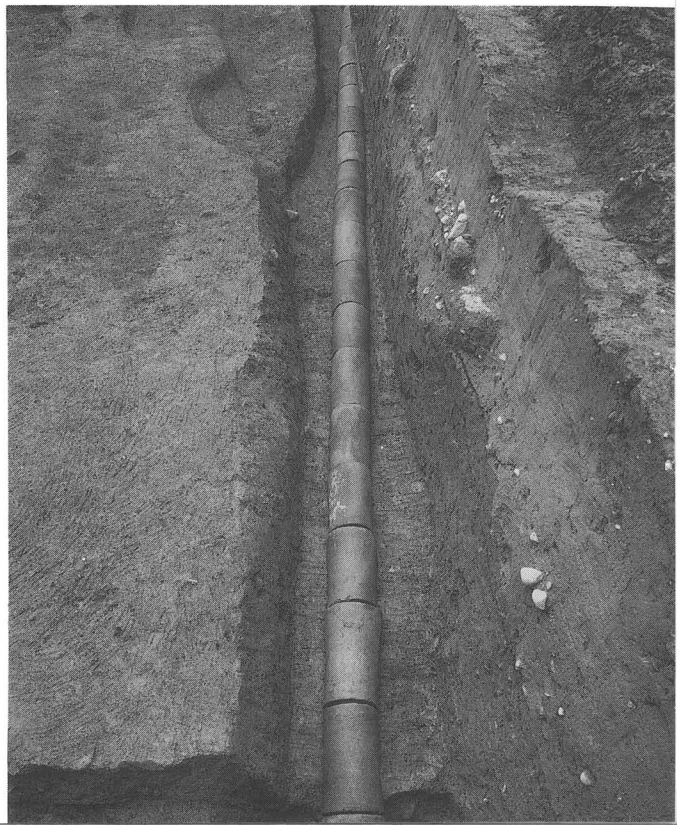
土管暗渠 SX06 (飛鳥寺1989-2次調査)
