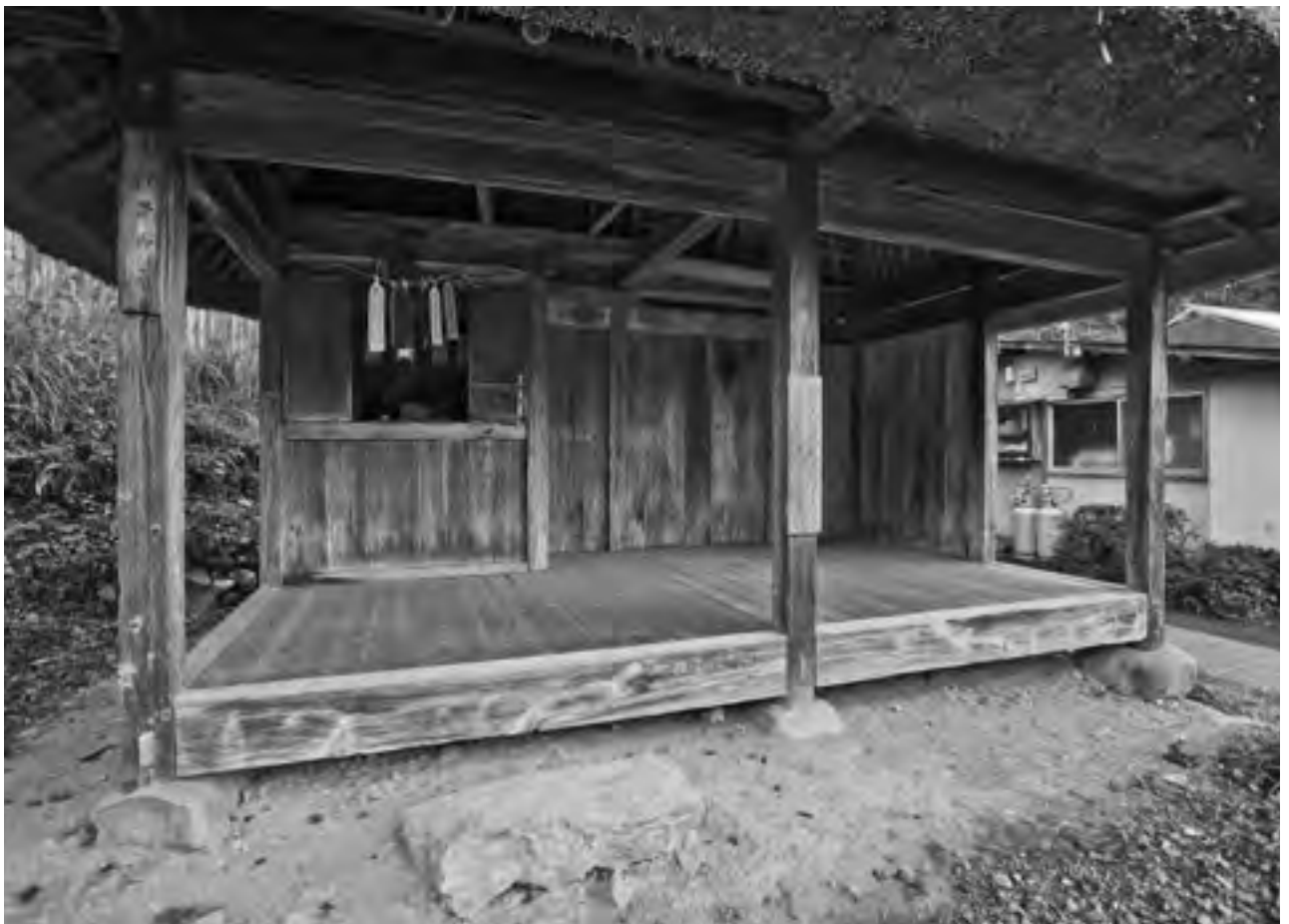
8 慶応元年建設の茶堂。間口中央に柱が立ち、祭壇と炉の空間が分節される。(梶原町川西路)
