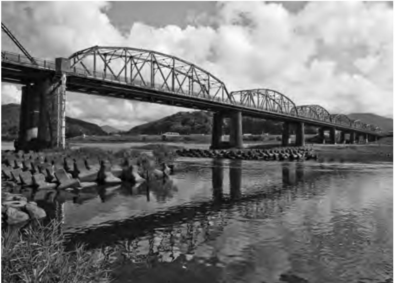
26 大正 15 年に竣工した赤鉄橋。帆のあるセンバも通過できる高さを持つ。(四万十市中村大橋通)
