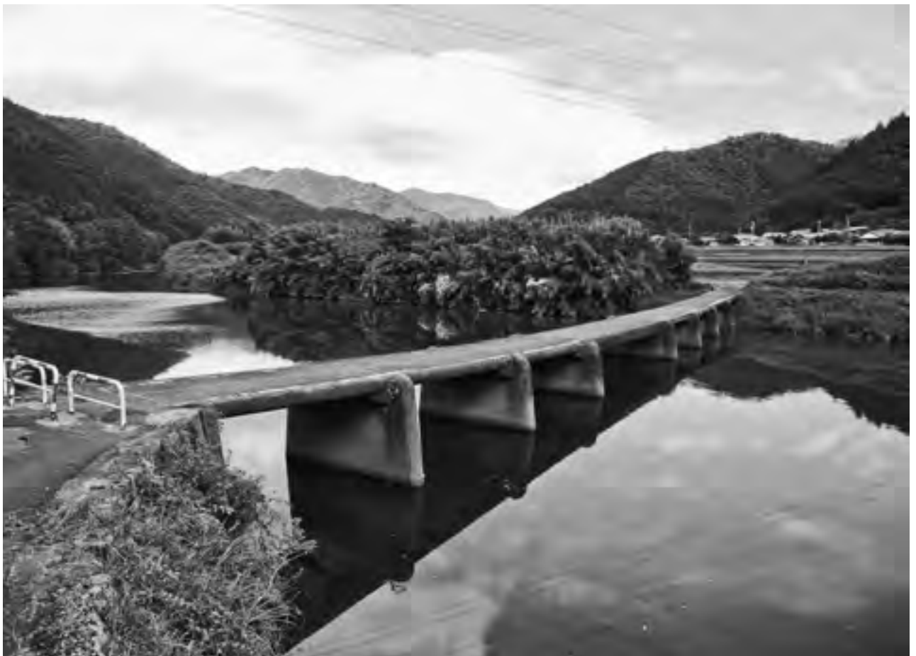
13 昭和 10 年に完成した一斗俵沈下橋。下流側に堰が築かれたため水深が深い。(四万十町壱斗俵)
