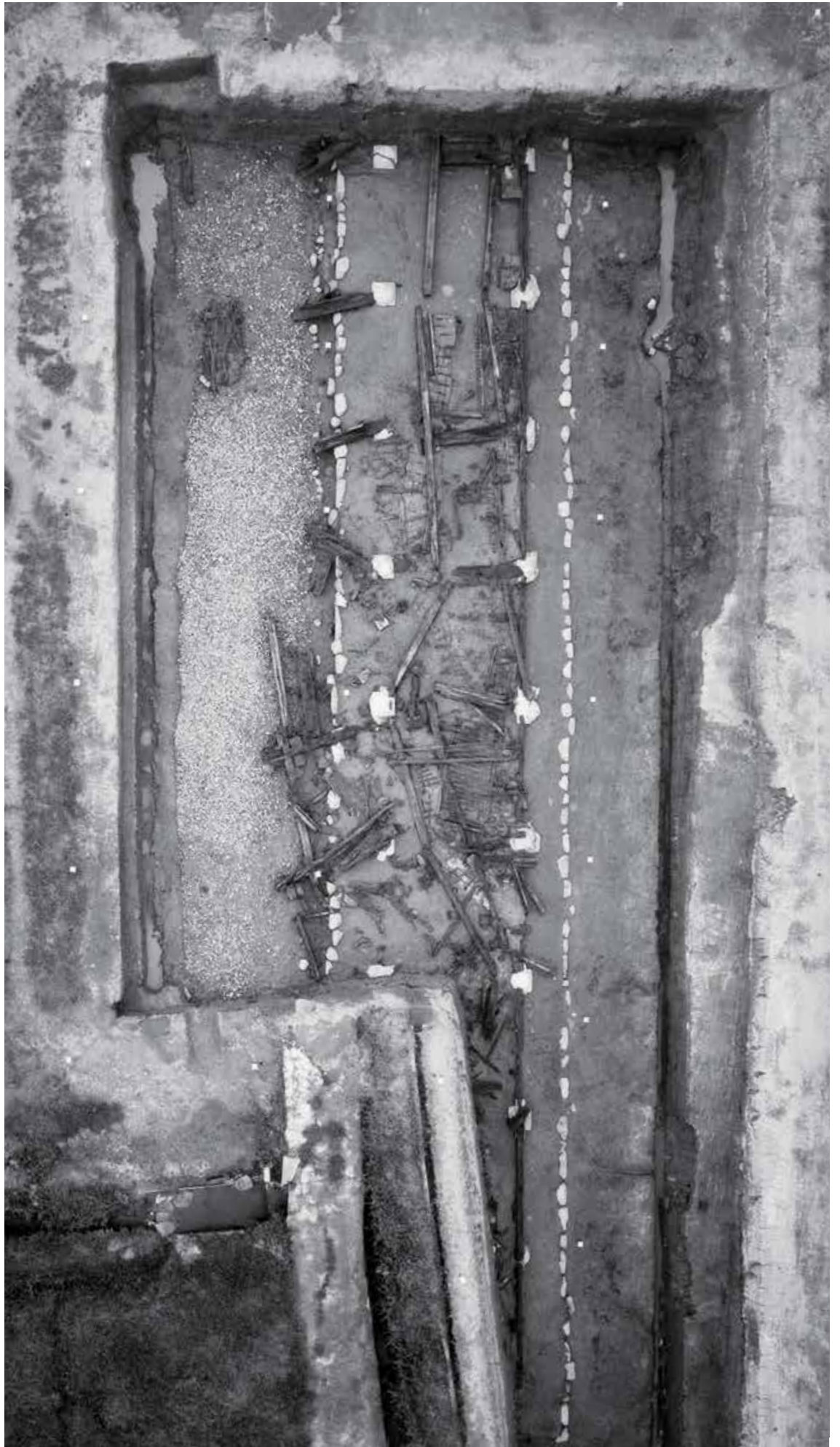
回廊建物倒壊状況(航空写真) 1 : 150
