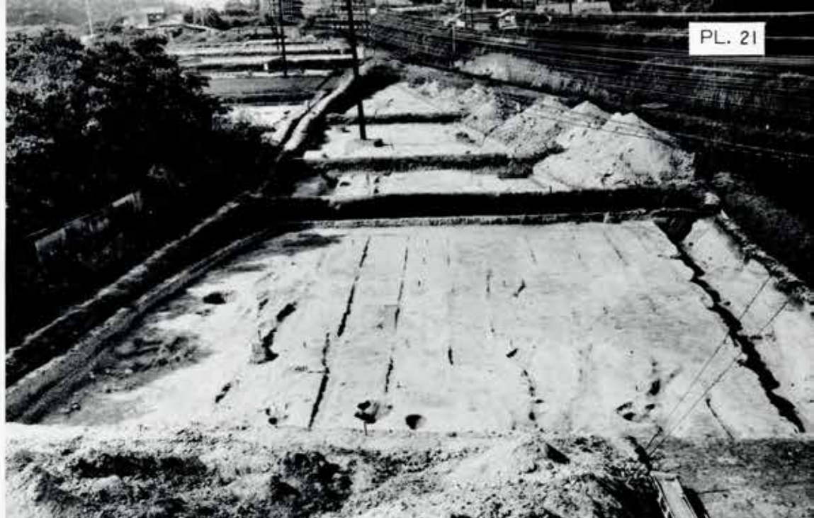
1. SX600大路 SD650溝 南から
