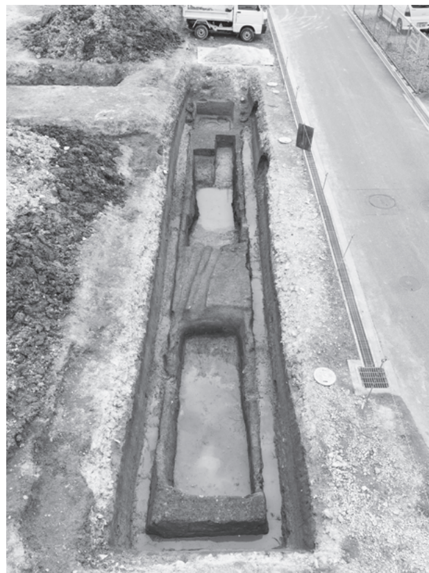
図247 第524次調査区全景（北から）
