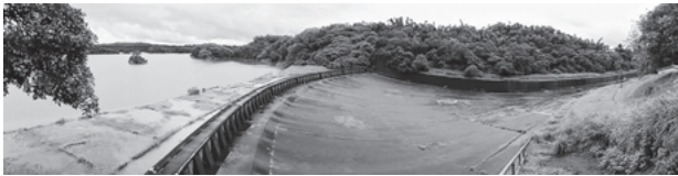
図48 烏山頭ダムの余水吐(1921年着工、1931年完成)
