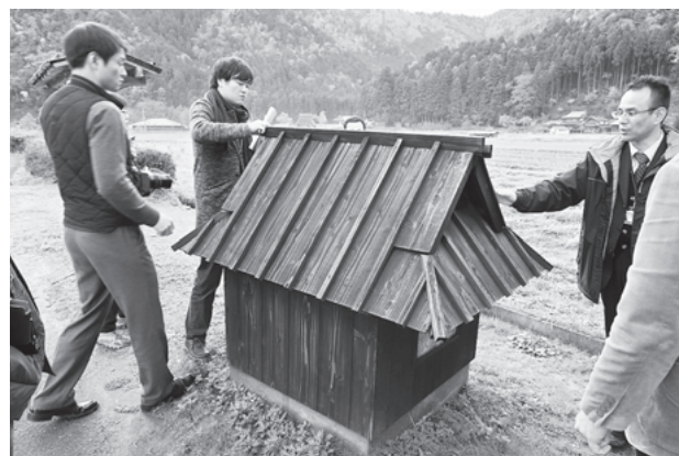
図 I-86 放水銃格納庫 (美山町)
