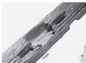
図266 上段土居桁（西側）の間柱部分の仕口
