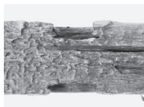
図268 上段土居桁（西側）の欠込部分
