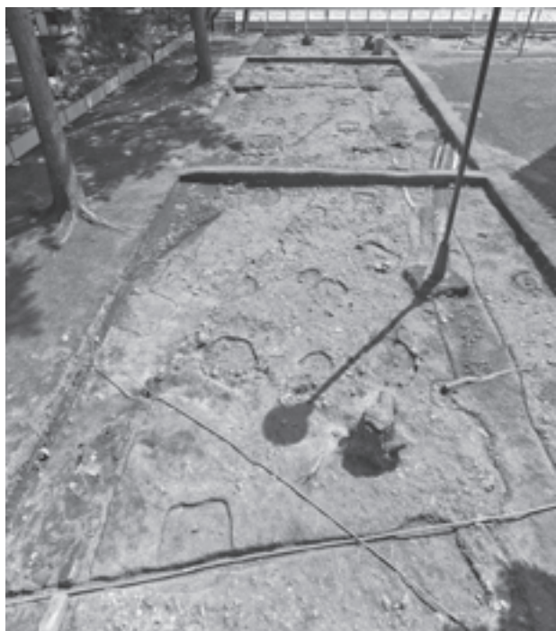
図209 東面回廊SC9950（北から）
