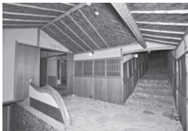
図50 井植山荘浴室棟前廊下
