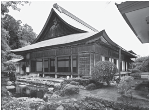
図35 竹林寺客殿 正側面（南西から）
