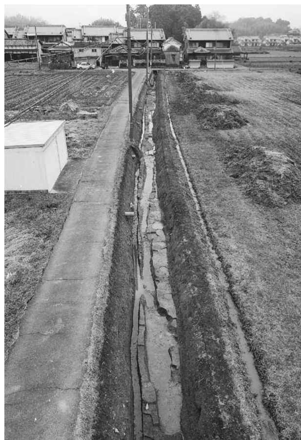
図69 第152-7次調査区全景（北から）
