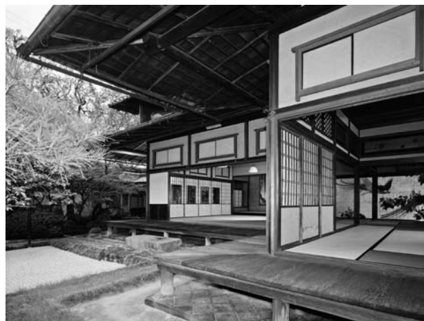
図11 宙を浮く軒桁（角屋松の間、京都市、大正15年）
