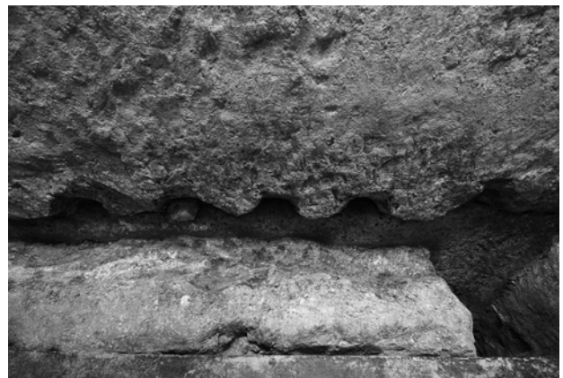
図100 南壁石南面下端の梃子穴
