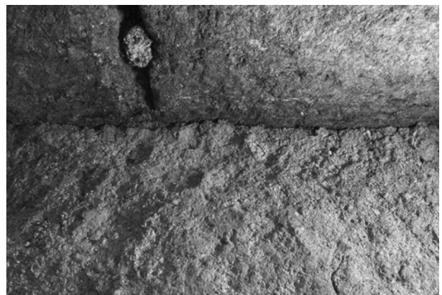
図104 床石周囲の作業面と搗棒痕跡（床石2東側）
