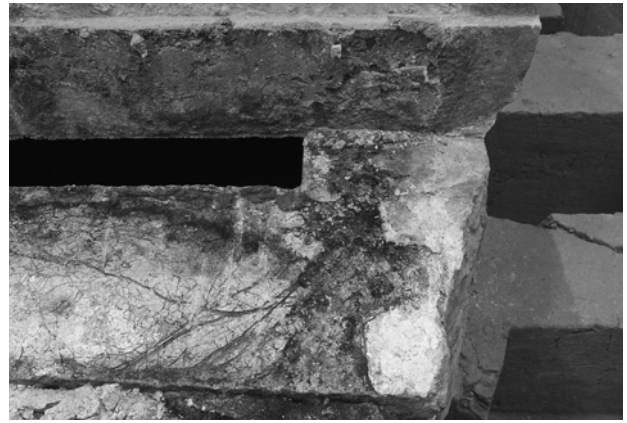
図112 接合面のカビと侵入した根（北壁石上面）
