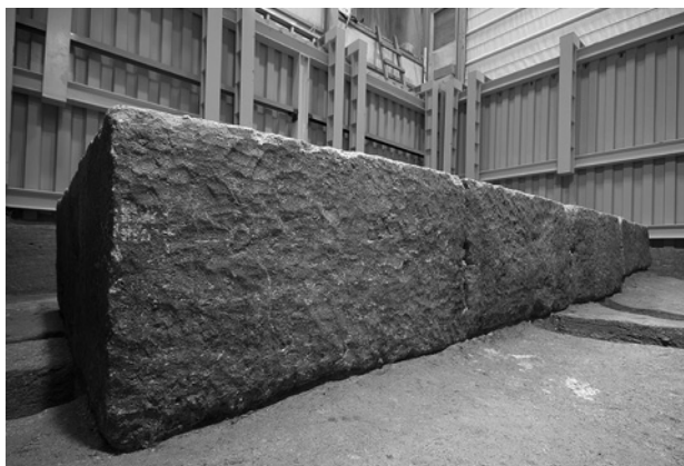
図103 厚さが不揃いの床石（南東から）
