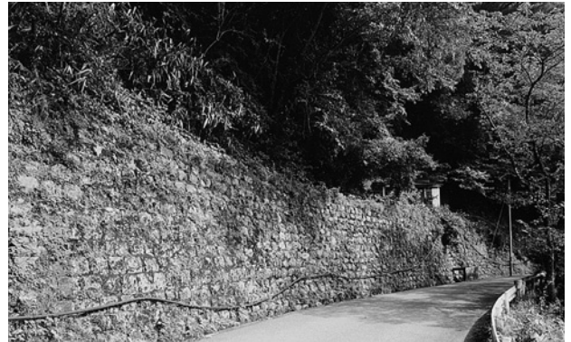
図58 馬路石積擁壁
