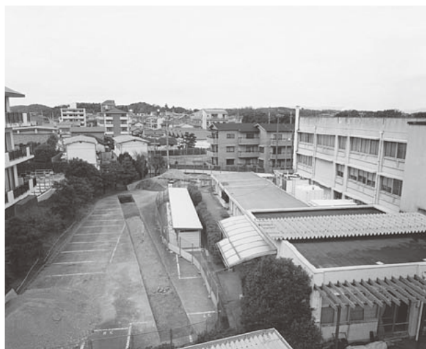
図211 西区全景（南側屋上から）
