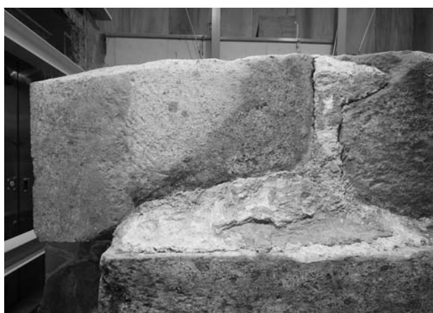
図146 天井石と壁石の目地を塞ぐ漆喰（天井石1・2と東壁石1）
