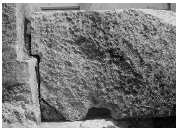
図147 天井石合欠きの組み合わせ（漆喰除去後の天井石3・4東側面）
