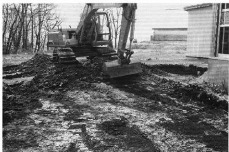
重機による表土除去
