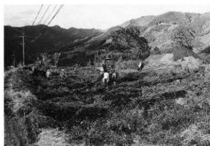
伐開作業状況
