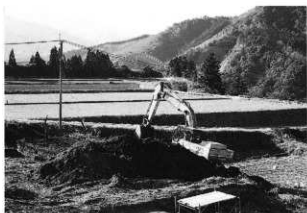
重機による表土剥ぎ状況
