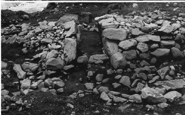
第24号墳羨門部 開口方向より
