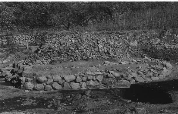
第23号墳填丘および据石 南より
