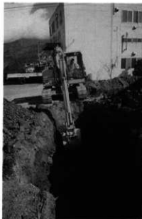
2号トレンチ調査状況 (南より)
