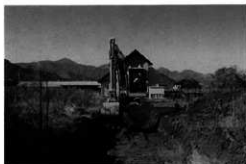
2号トレンチ調査状況 (東より)
