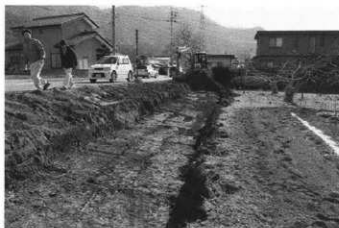
トレンチ検出状況 (北より)
