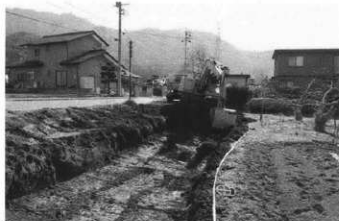
トレンチ掘削状況 (東より)
