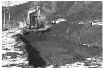
掘削状況 (東より)
