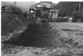
トレンチ検出状況 (東より)
