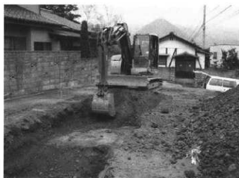
トレンチ掘削状況 (東より)
