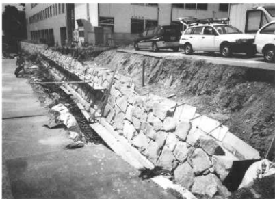
石積み状況 (折点より北側)
