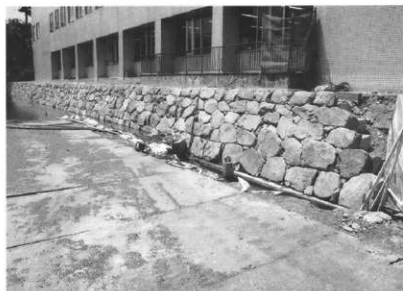
15年度分の石積み完了状況
