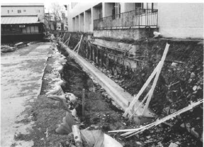
コンクリート布基礎打設状況
