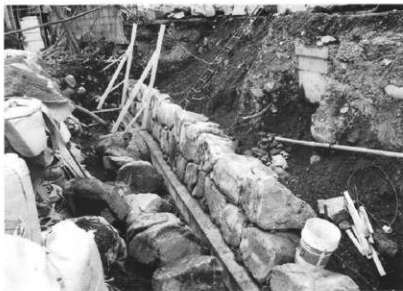
石積み状況(南端部)
