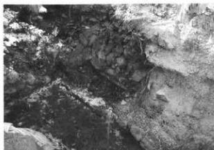
南端部の石垣の内側に検出された石垣の状況
