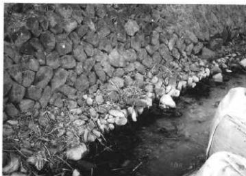
石垣脚部の補強工（基準番号15～16付近）
