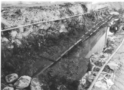
既存石垣解体後の状況 (基礎鋼木が見えている)
