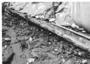
枕胴木と止杭の状況。(基準番号14付近)
