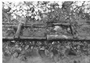
梯子胴木の状況。継手は突き付け(基準番号10付近)
