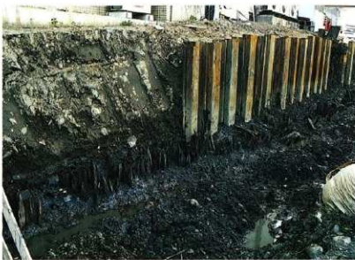
第2次調査 (杭列・南側より)
