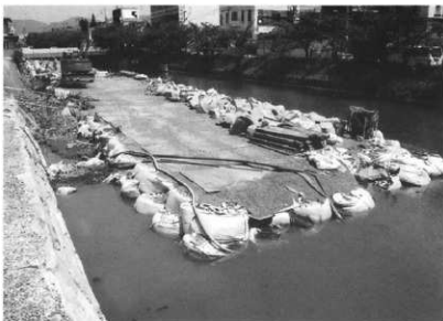
仮設道路短縮状況
