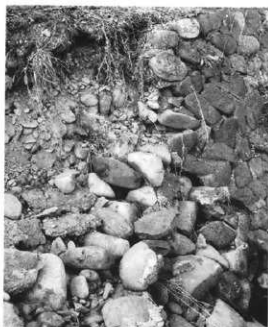
石垣内部の状況（基準番号22の南側）
