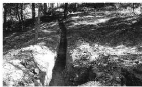
同 トレンチ調査
