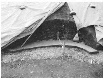
東法面擁壁の基礎 池状遺構の抉り込み部分に設けた 擁壁基礎部分
