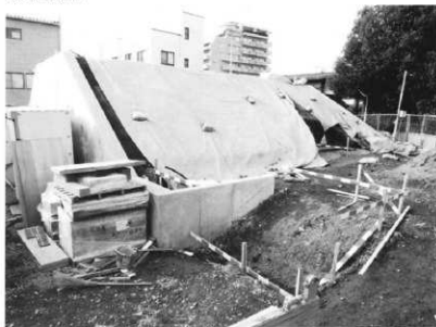
土塁成形完了及び階段丁張り 遺構への影響を考慮し、階段を当初 計画から縮小
