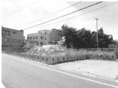
着手前 現場全景・遺構養生
