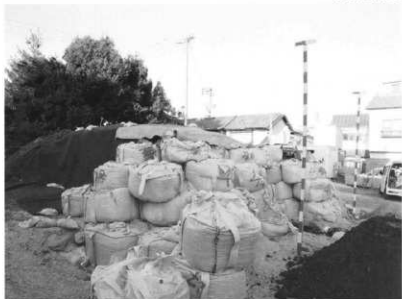
擁壁工 南側擁壁丁張りと遺構養生用土嚢
