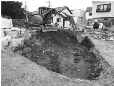
南側擁壁基礎部掘削
