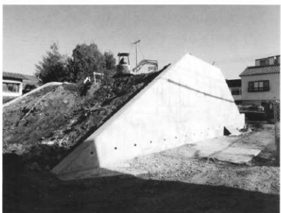
南側擁壁コンクリート打設完了
