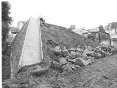
北側擁壁の造成
