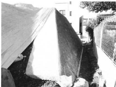
北側擁壁完了(東から)
