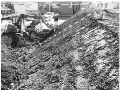
土墨東法面丁張り設置 重機にて法面の成形を行う
