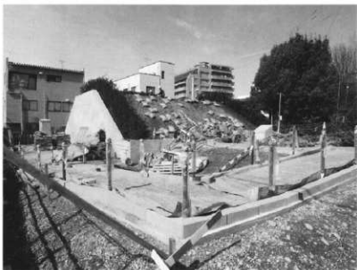
広場東南隅から全体 手前がスロープの施工中 奥に植栽中の土墨が見える
