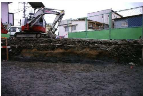
南側擁壁掘削立会い調査 南東壁の地山層と攪乱状況
