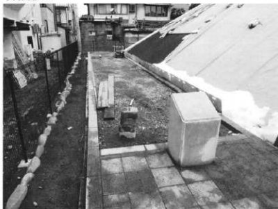
土墨西側 東面同様カラー舗装の路床が整えられ、 手前に尖状抗列説明板躯体が据わる
