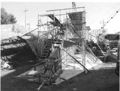
南側擁壁コンクリート 立上り部打設・型枠状況
