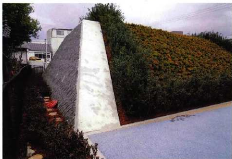
同上 北西から
