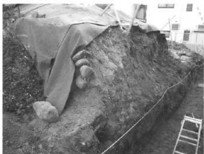
北側擁壁 土塁の残存状況
