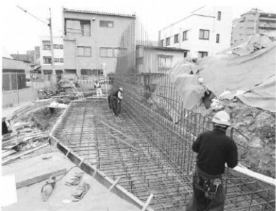
南側擁壁配筋 立上り部分の配筋施工
