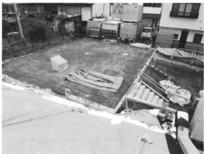
武家屋敷跡整備施工中
