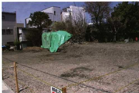
事業地全景 (南東から)
