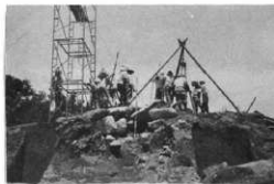
285. 大きな天井石はチェンブロックでつり上げた
